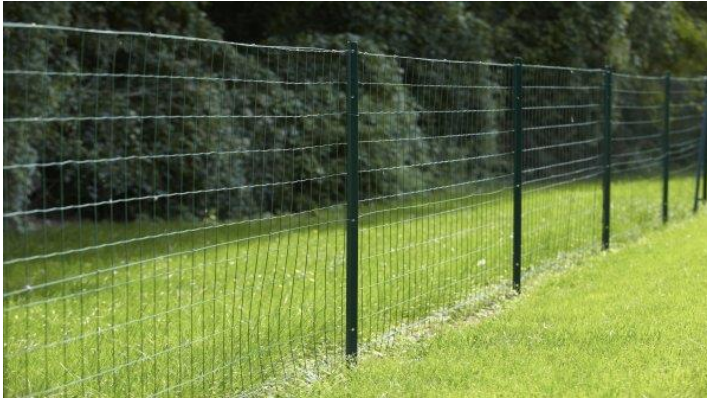
Clôture métallique rigide sans soubassement.
